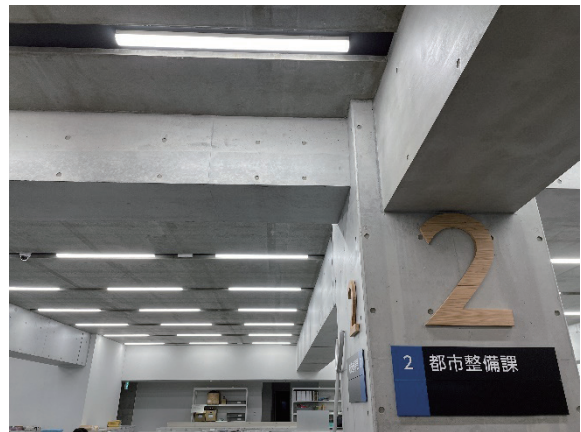
写真4 執務室の無天井部分
