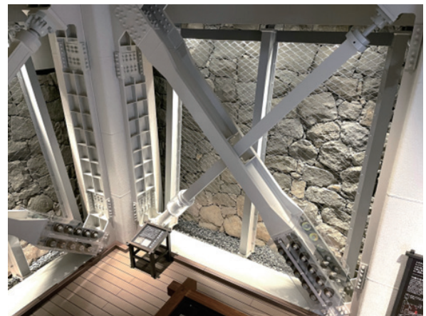
写真7 クロスダンパー裏側の石垣安全対策
