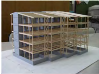
RCコアにとりつけた構造 木造で開放的な空間 低層ならRCコアをCLTに
