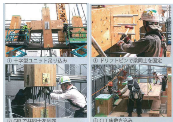
図12 木造躯体建方状況
