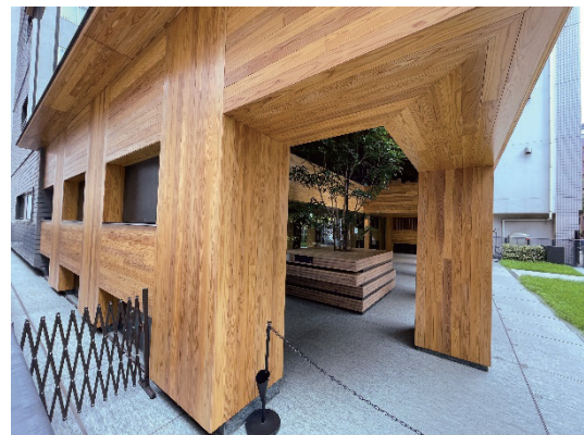
写真7 建物コーナー免震EXP部
