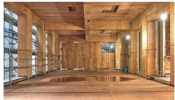
図9 CLT壁設置状況
