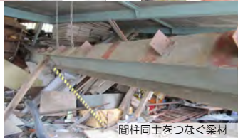
1階柱頭部の破壊 (日の字柱、弱軸曲げ)
