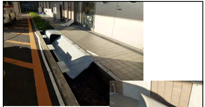
周囲のクリアランス カバーの被害
